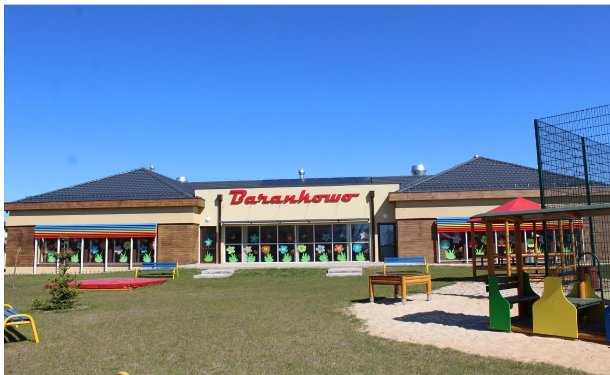
Zdjęcie przedstawiające budynek główny Żłobka od strony placu zabaw
