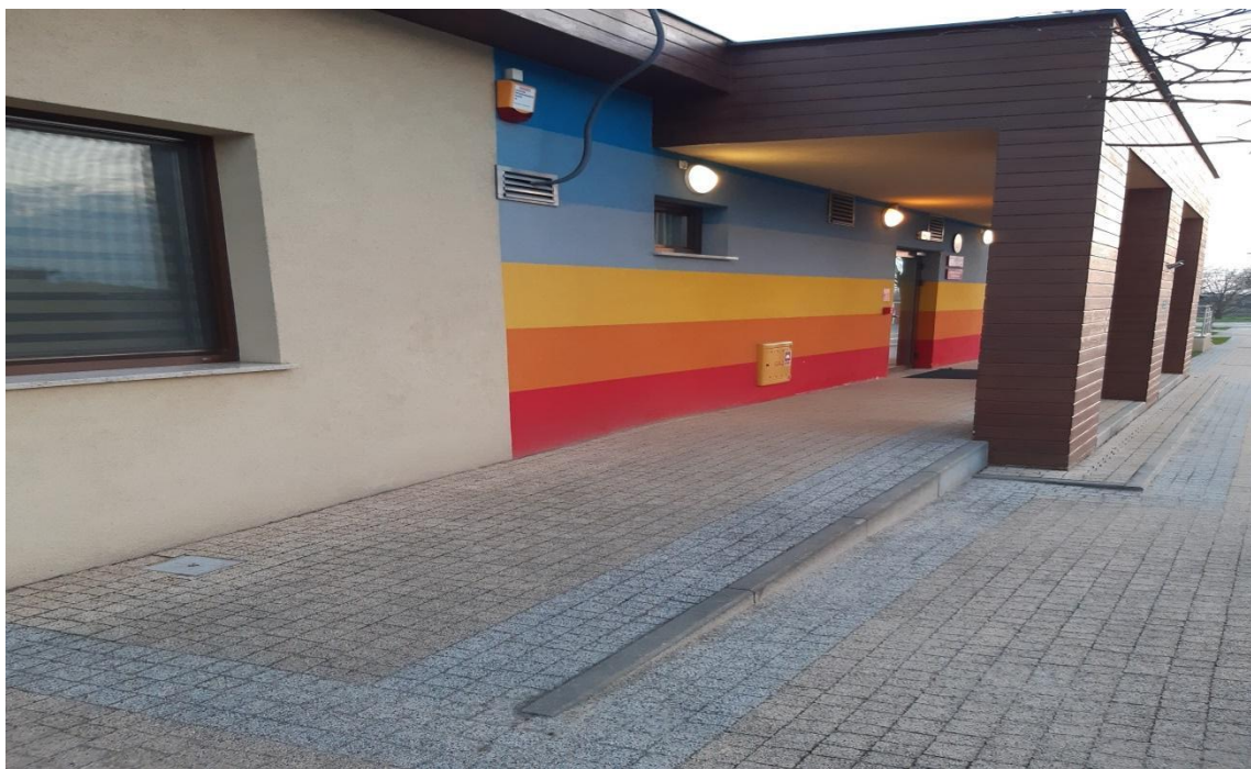
Zdjęcie przedstawiające podjazd do budynku od strony ulicy Jana Pawła II dla mam z wózkiem oraz osób poruszających się na wózkach inwalidzkich
